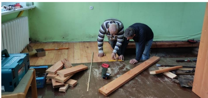
3.1.att. Grīdas remonts Aizkalnes bibliotēkā
